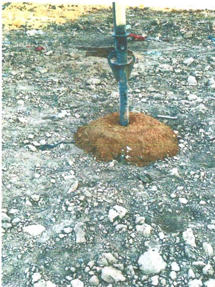
Execução de tradagem mecanizada afim de determinação do perfil de solo.
