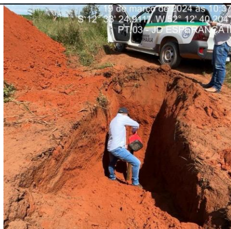
FOTO 06: Execução ensaio de permeabilidade solo.
