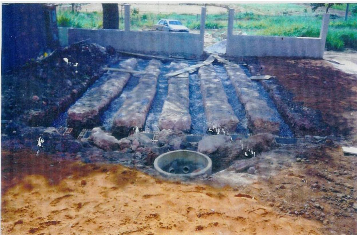
Figura 5 – Valas de Infiltração - Ilustração.
