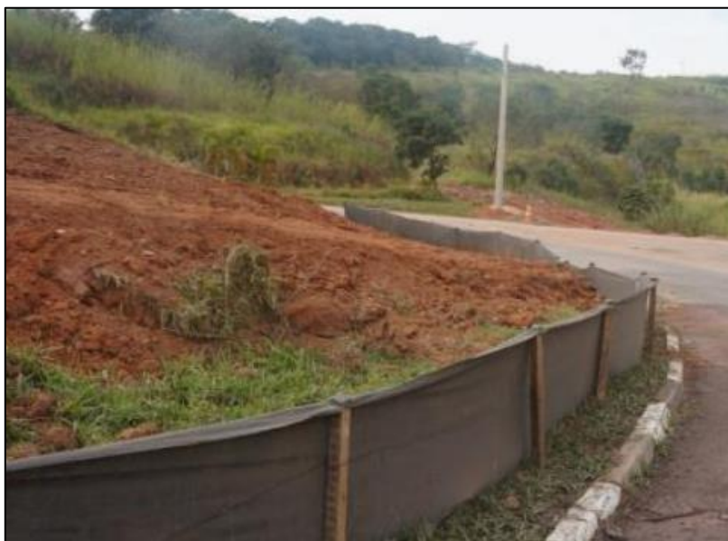
Figura 5.1 – Contenção de sólidos com manta geotêxtil
