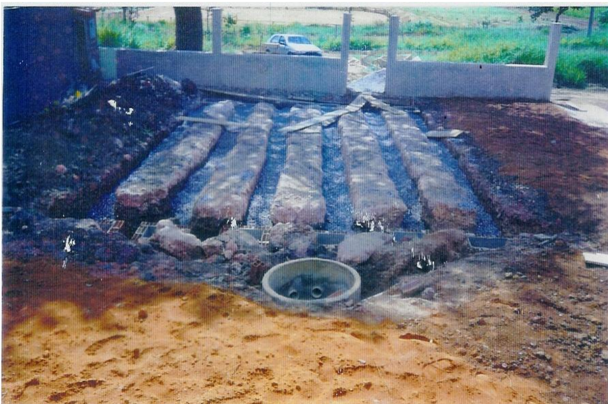
Figura 5 – Valas de Infiltração - Ilustração.
