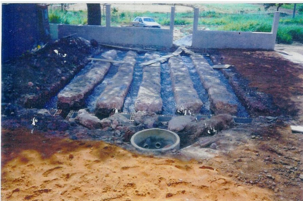
Figura 5 – Valas de Infiltração - Ilustração.
