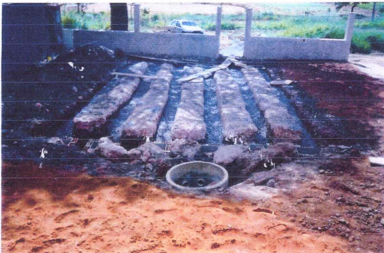
Figura 5 – Valas de Infiltração - Ilustração.
