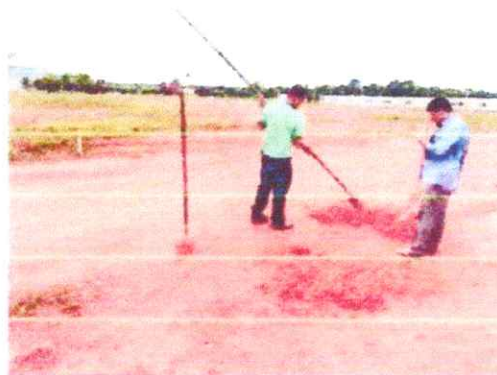
Execução de Tradagem de Solo
