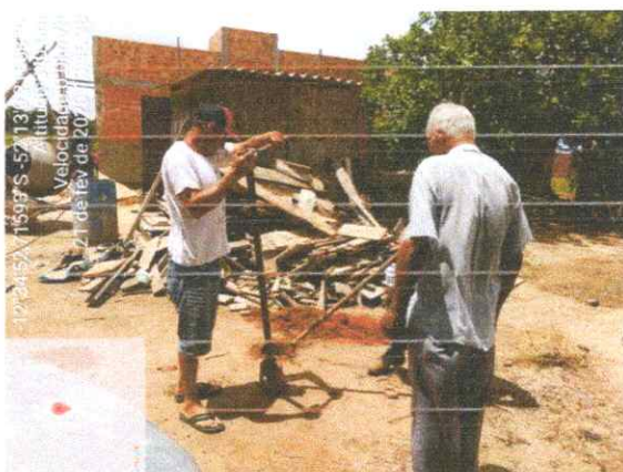
Vista do local do Empreendimento
